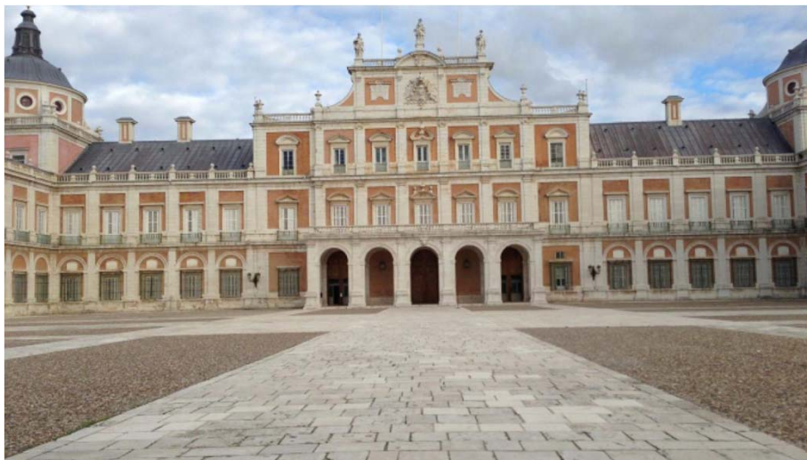
Palacio de Aranjuez. Fachada principal (1748)
